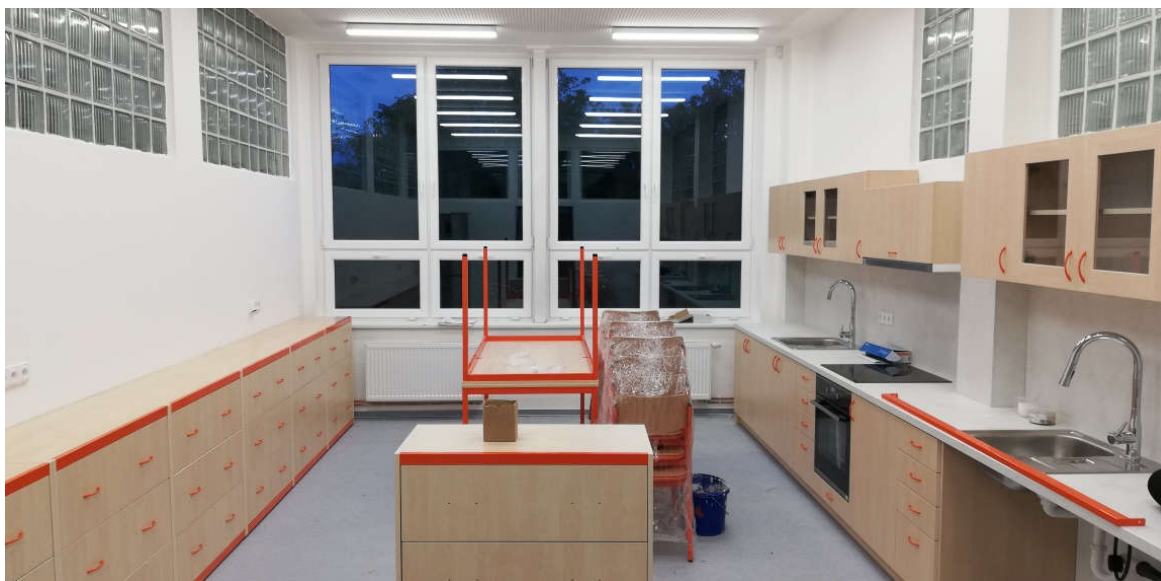
Foto: Interiér opravené budovy B. Dále fotografie z rekonstrukce.
